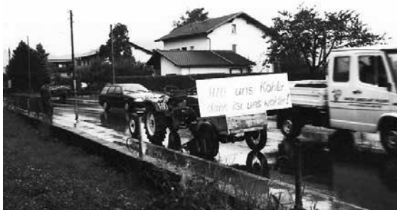
Brederis 1990: Bau der L52, Blockade 3 mit Proberückbau
